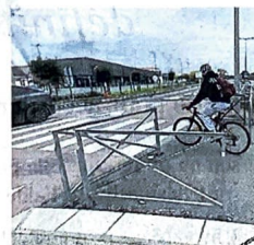
En face du Lidl, près du rond-point du E. Leclerc, le passage vélo a été modifié et des barrières ont été installées.
